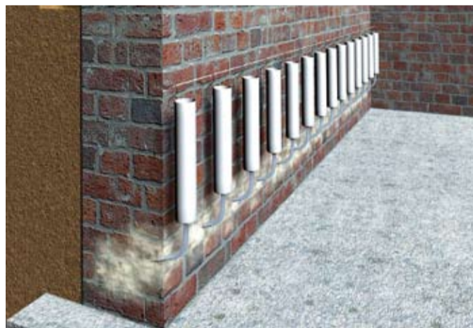
Uszczelnienie budowli w systemie Kiesol
