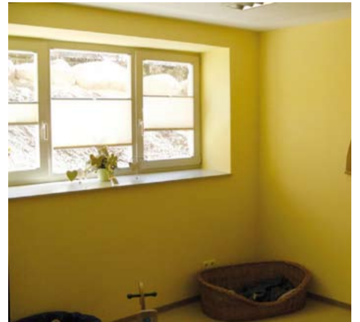
Przedszkole w podziemnej części budynku po remoncie
