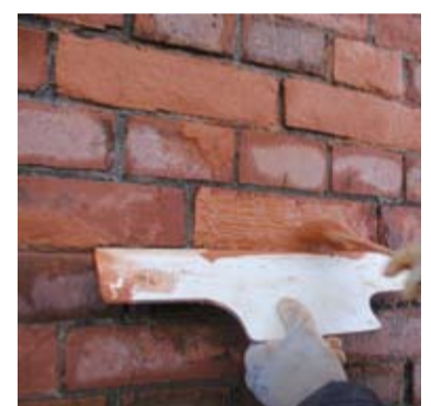
Szlamowanie spękanych cegieł
