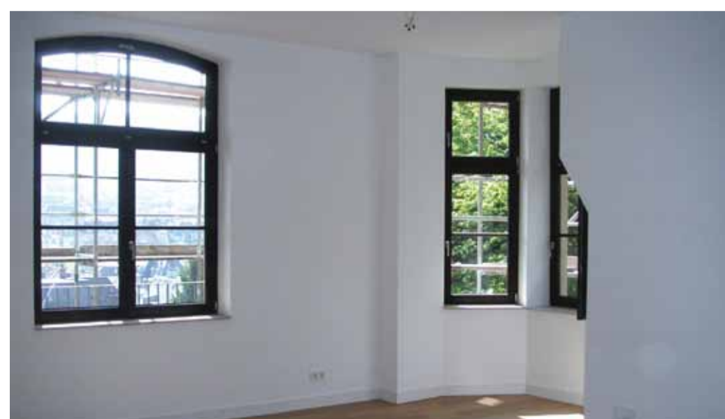
Widok jednego z pomieszczeń po zakończeniu prac renowacyjnych.
