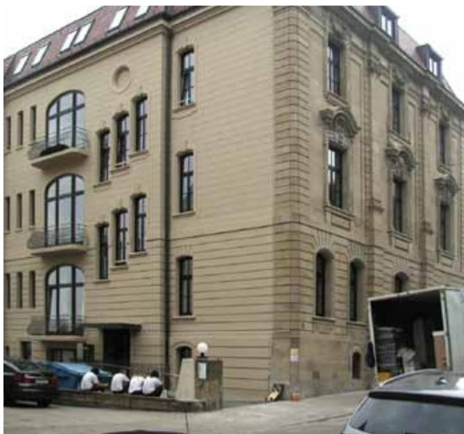
Przebudowa kamienicy w Stuttgarcie, Mörickestraße
