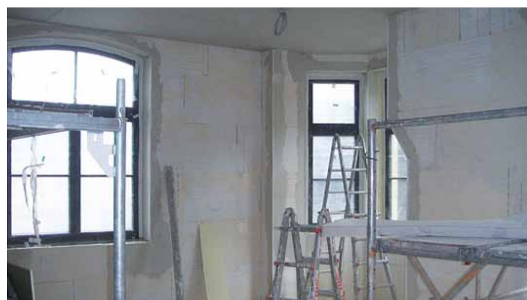
600 m 2 ścian otrzymało wewnętrzną izolację termiczną z iQ-Therm 50
