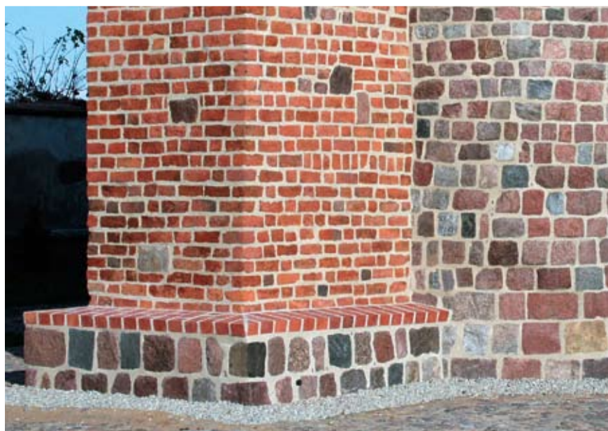
Fragment rotundy po przeprowadzeniu prac konserwatorskich
