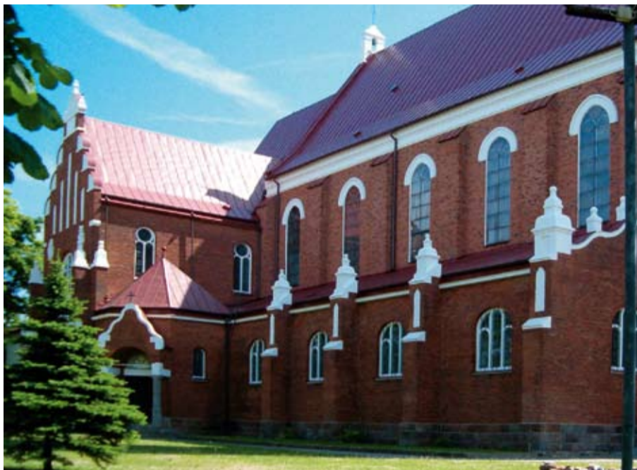
Odsłonięcie historycznej elewacji, impregnacja hydrofobizująca i odrestaurowanie cegieł za pomocą systemu Funcosil
