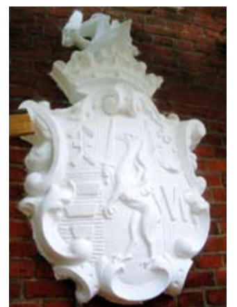
Detal architektoniczny przed i po przeprowadzeniu prac konserwacyjnych
